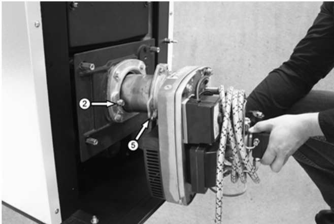
Abb. 4: Brennerbefestigung
