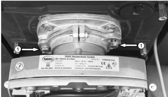
Abb. 19: Brennerbefestigungsschrauben ①
