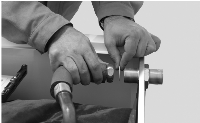
Abb. 32: Verbliebene Seite vom Rohr (Kessel/Kesselsicherheitsgruppe) an den Doppelnippel 1" der Rückwand anschrauben. Bei der Baureihe EcoStar 750 zusätzlich das im Zubehörset enthaltene Verlängerungsrohr (Sach-Nr. 94.16144-5411) installieren.
