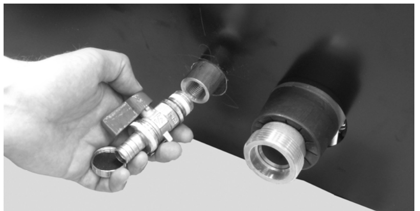
Abb. 59: KFE-Hahn montieren.
