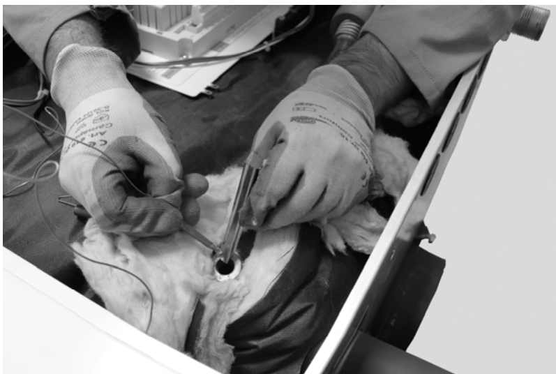
Abb. 56: Kapillare und Kesseltemperaturfühler auf die Ankopplungsfeder aus dem Zubehör-Set EcoStar 720/750 legen. Kesseltemperaturfühler und Sicherheitstemperaturbegrenzer mit Wärmeleitpaste bestreichen und zusammen mit Ankopplungsfeder in Tauchhülse am Kessel einführen.
