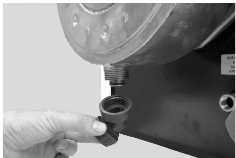
Abb. 46: Montage Ablaufbogen am RWT.
