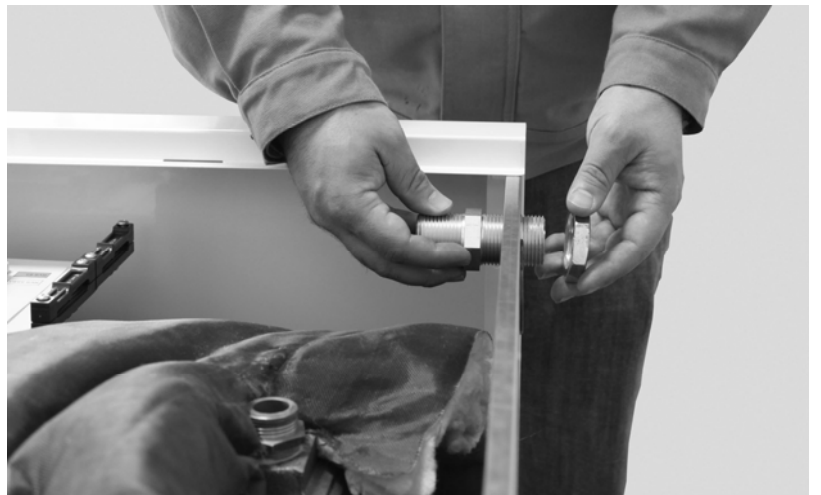
Abb. 30: Doppelnippel 1" mit der längeren Seite von innen durch die Rückwand stecken und mit Mutter verschrauben.
