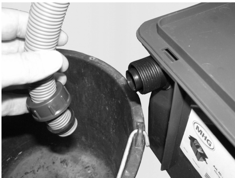
Abb. 96: Überwurfmutter des Kondensatschlauches abschrauben und Kondensatschlauch in einen geeigneten Behälter hängen.
