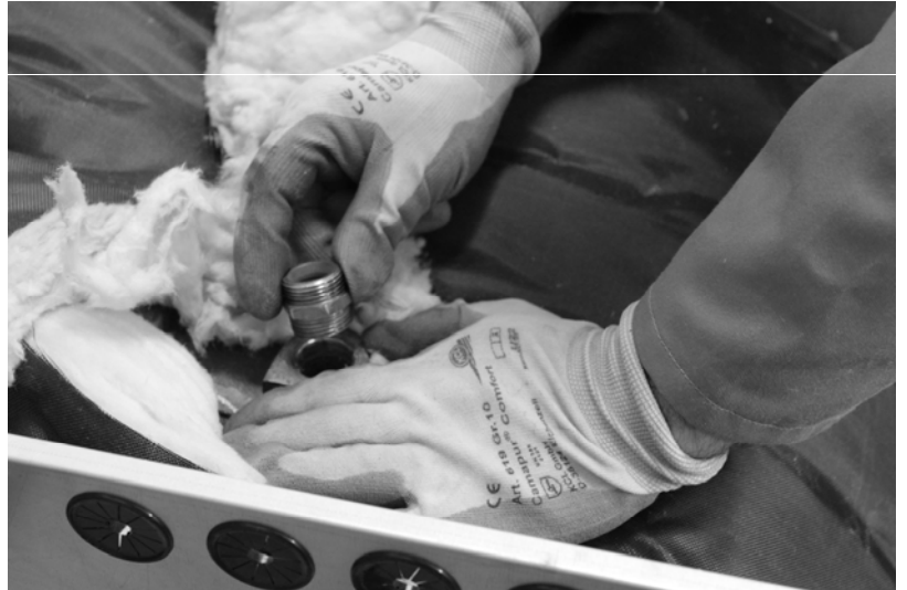
Abb. 29: Doppelnippel R \frac{3}{4} , G \frac{3}{4} für Rohr Sicherheitsgruppe ein-dichten und einbauen. (035)
