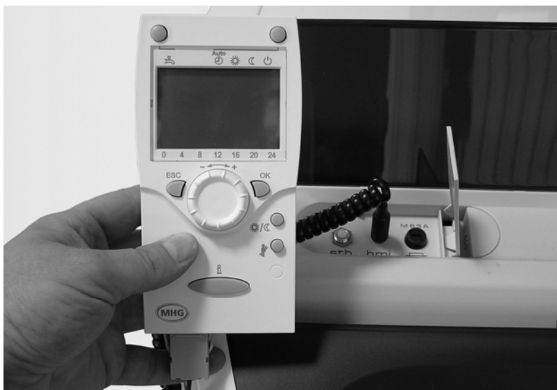
Abb. 69: Verbindung der Bedieneinheit QAA 75 mit dem Kesselschaltfeld.
