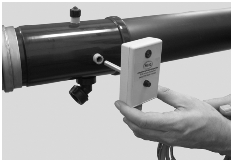
Abb. 98: Abgastemperaturbegrenzer herausziehen und auf Verschmutzungen überprüfen.
