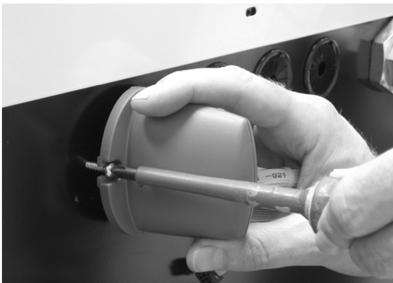
Abb. 73: Das Funkmodul an der Verkleidungsrückwand montieren.
