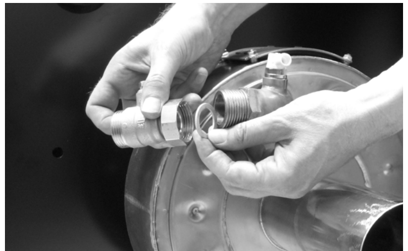
Abb. 39: Kugelhahn an Ringwärmetauscher anbauen.
