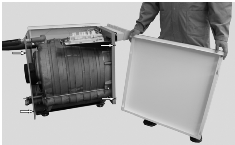
Abb. 27: Seitenverkleidung in die vier Rasthaken einhängen.
