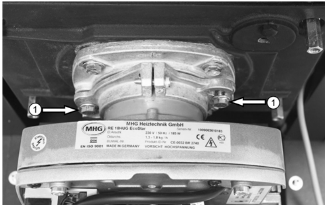
Abb. 32: Brennerbefestigungsschrauben
