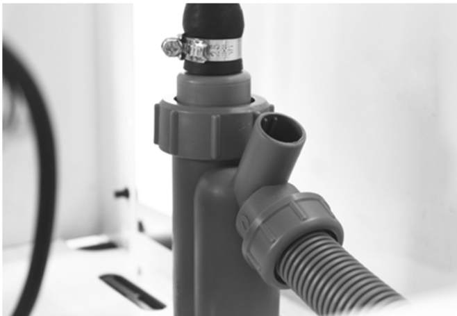
Abb. 11: Siphon und Kondensatschlauch
