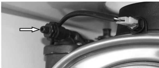
Abb. 29: Kesselkörper-Entlüfter
