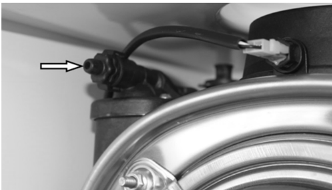
Abb. 24: Kesselkörper-Entlüfter
