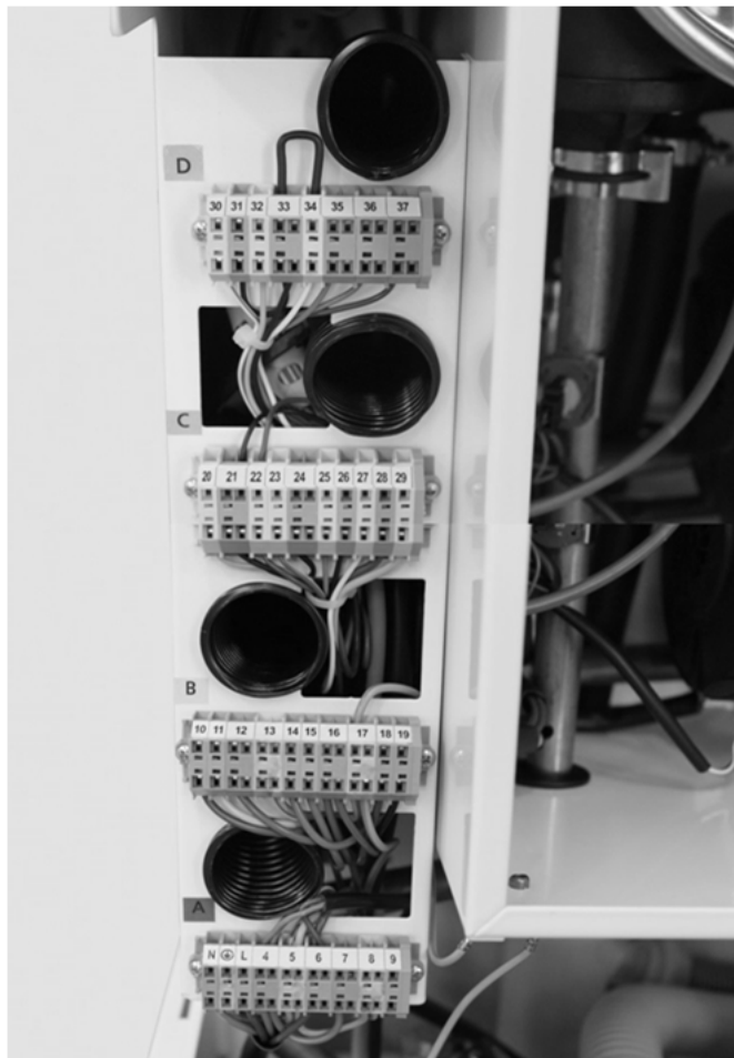
Abb. 18: Elektrische Anschlussklemmen ProCon E...
