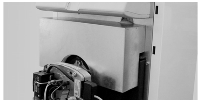
Abb. 7: Montierte Kesseltürisolierung (Nur bei EcoStar 500 und EcoStar Hybrid)
