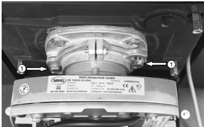
Abb. 25: Brennerbefestigungsschrauben ①
