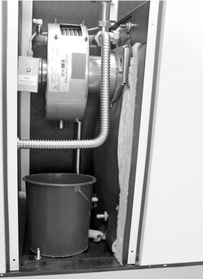
Fig. 62 : RWT préparé pour le nettoyage
