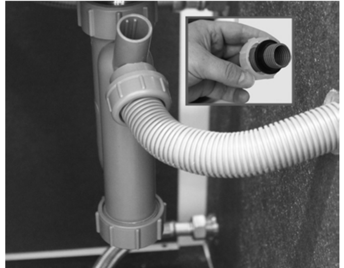
Fig. 8 : Montage du tuyau des condensats
