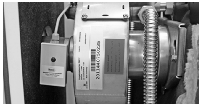
Fig. 19 : Limiteur de température des gaz de fumées (ATB) monté d'usine
