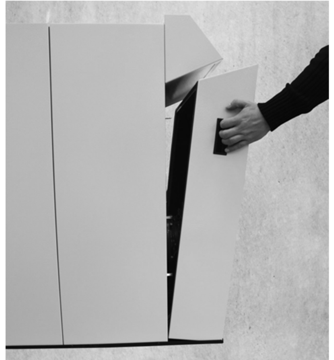
Fig. 55 : Démontage du capot chaudière
