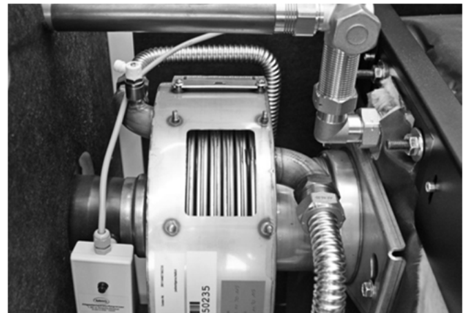
Fig. 61 : Une des ouvertures de nettoyage du RWT
