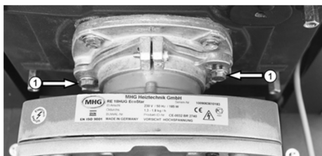
Fig. 18: Vis de fixation du brûleur ①
