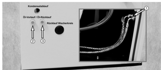
Fig. 9: Montage des tuyaux de fioul/mazout
