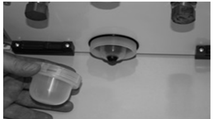
Fig. 8: Siphon de chaudière
