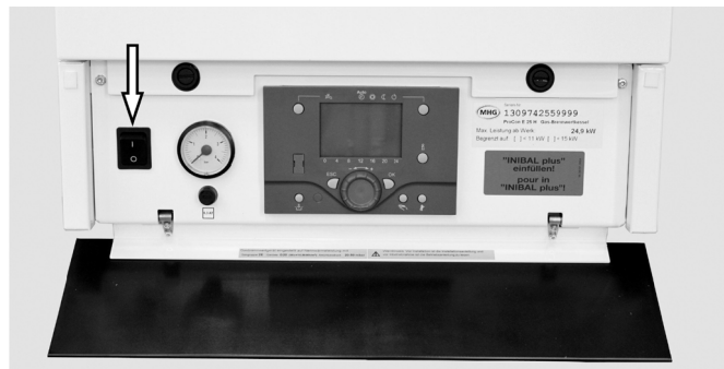
Fig. 2 : Panneau de commande avec interrupteur marche/arrêt
