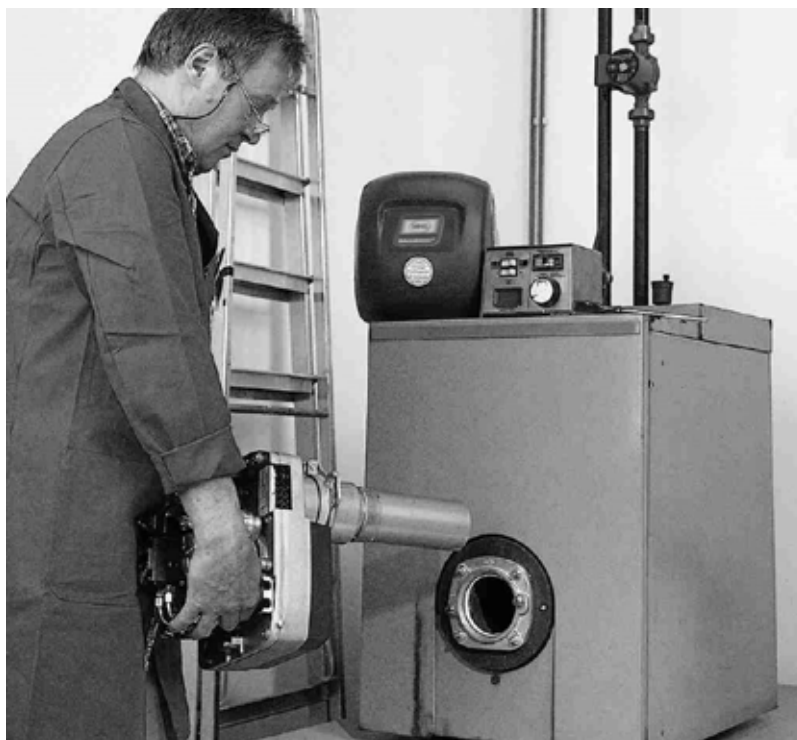
Fig. 10: Montage brûleur – chaudière I
