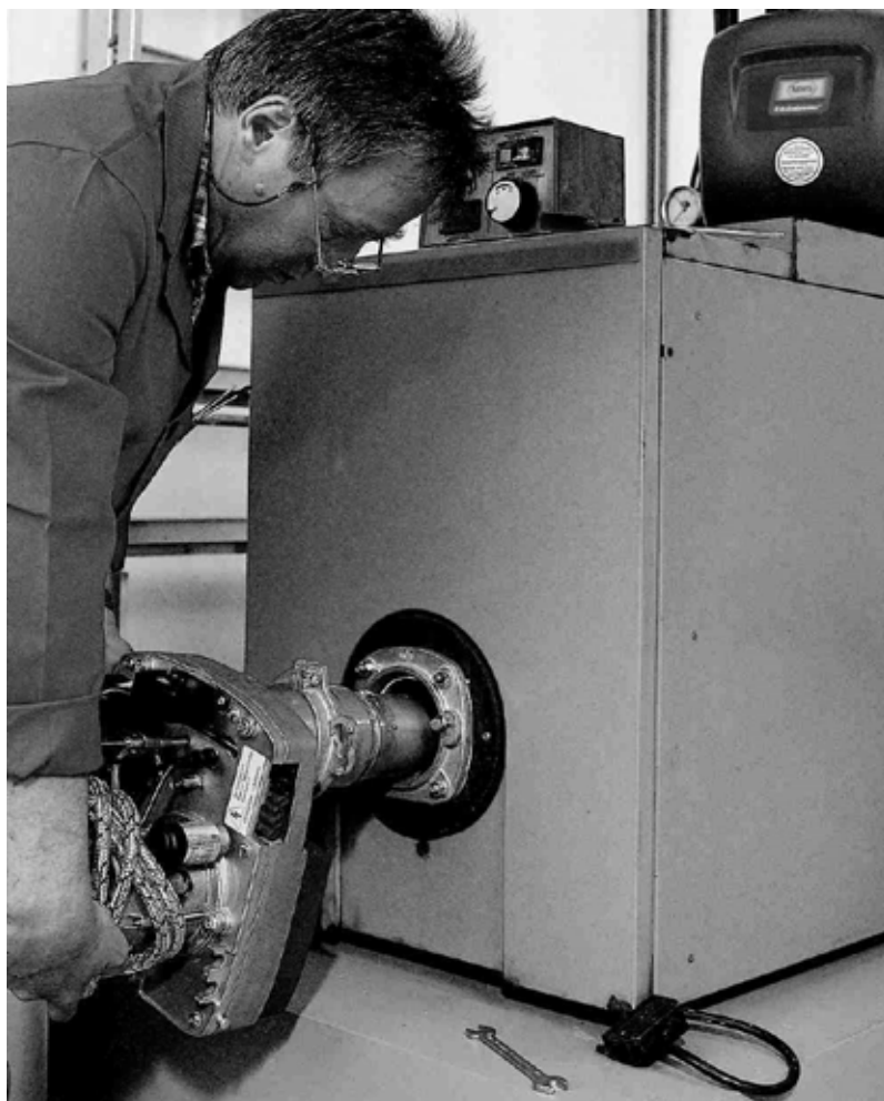
Fig. 11: Montage brûleur – chaudière II
