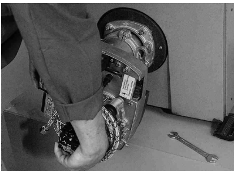
Fig. 12: Montage brûleur – chaudière III
